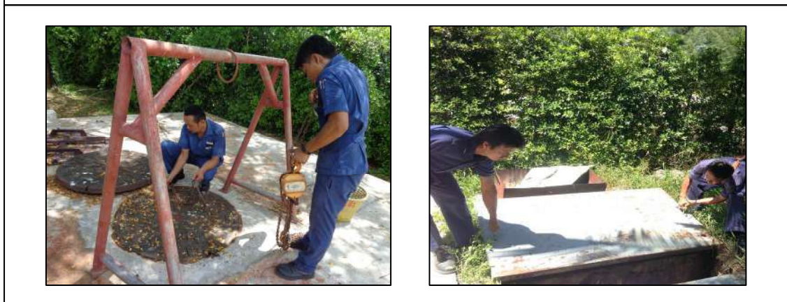
ภาพที่ 2-4 เจ้าหน้าที่ดูแลระบบบำบัดน้ำเสีย / ตักไขมัน
